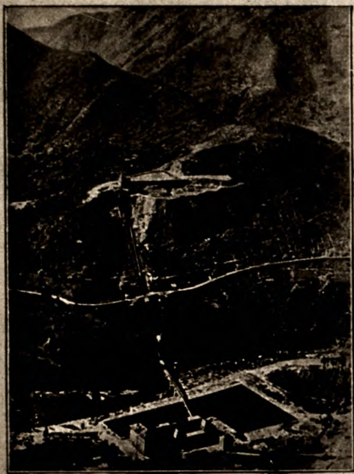
SERBATOIO ARTIFICIALE E CONDOTTA FORZATA IN VAL DI LANZO.
