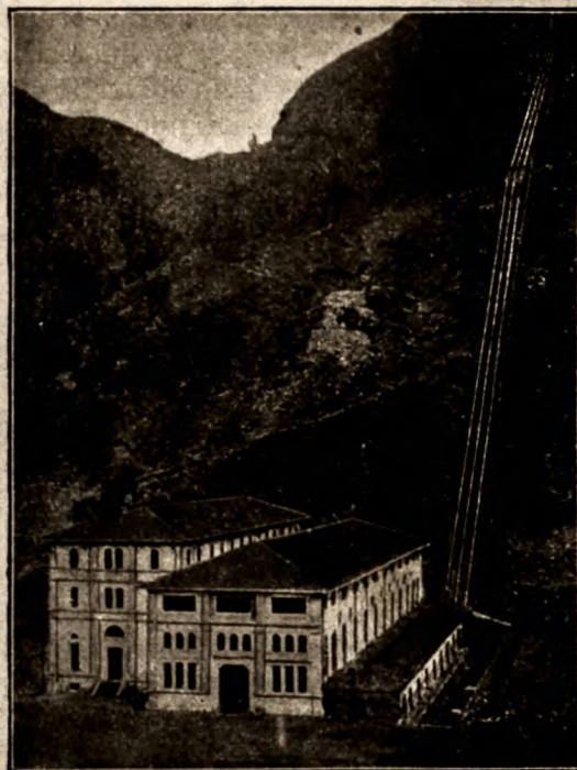
CENTRALE ELETTRICA E TRIPLICE CONDOTTA FORZATA IN VALCAMONICA.
