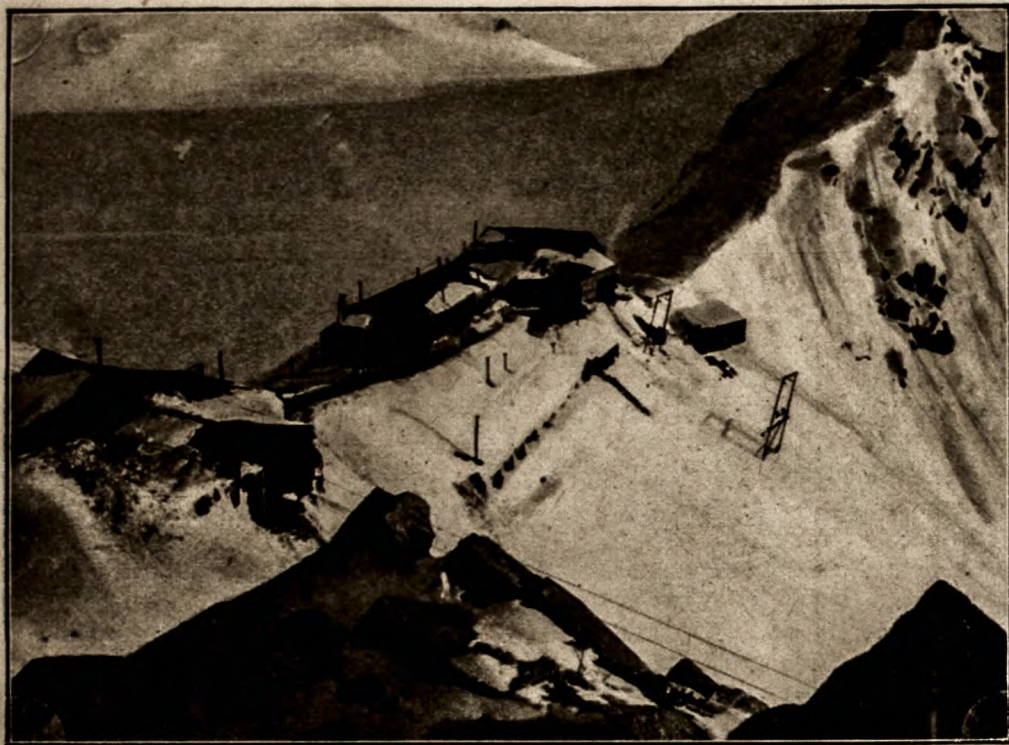
BARACCAMENTI ALPINI E TELEFERICA AL PASSO GARIBALDI (M. 3100). — Fot. Gualco.
