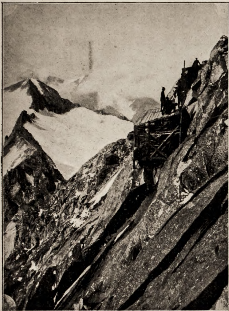
BARACCAMENTI ALPINI IN COSTRUZIONE SUL CORNO DI CAVENTO.
