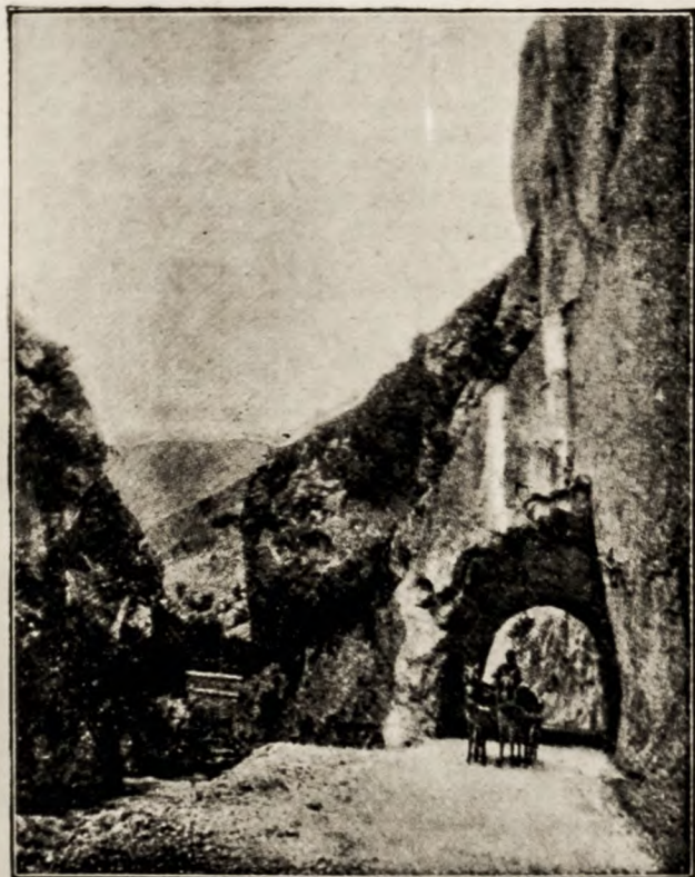
GOLE DEL SAGITTARIO, IL TUNNEL DELLA ROTABILE.
