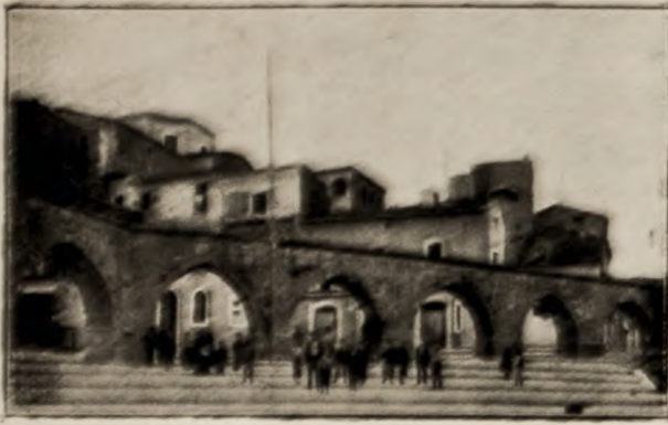
SULMONA: ACQUEDOTTO MEDIOEVALE.
