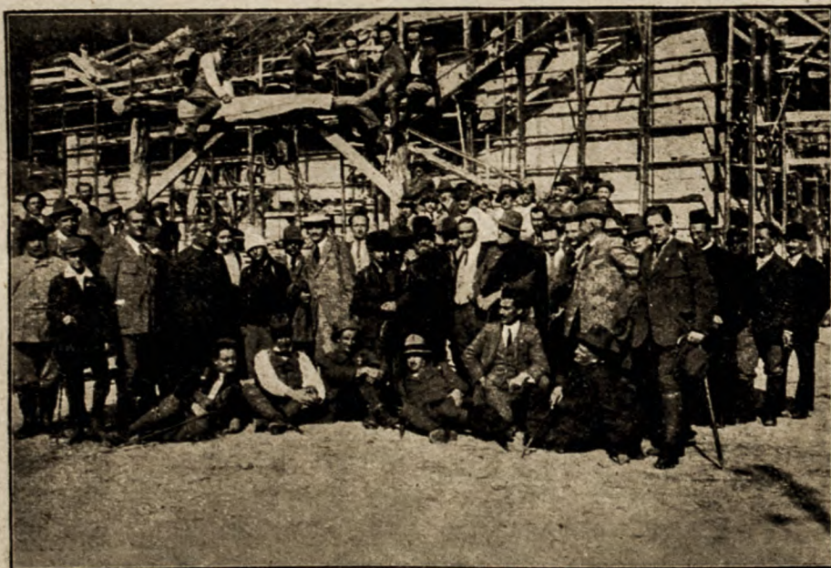
FORMAZZA. — LA CENTRALE ELETTRICA IN COSTRUZIONE.
