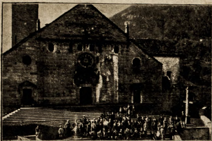
CHIESA DI BACENO. — Neg. Frattini, Domodossola.
