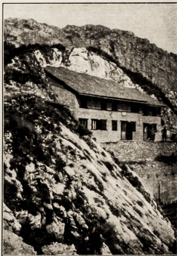
La baracca del Comando Settore Padola-Visdende trasformata dopo la guerra in Rifugio (Rif. Olivo Sala in Popera) dalla Sezione Padova C. A. I.
