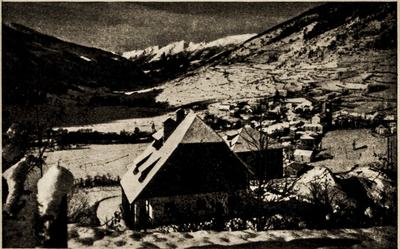
PONTE DI LEGNO
