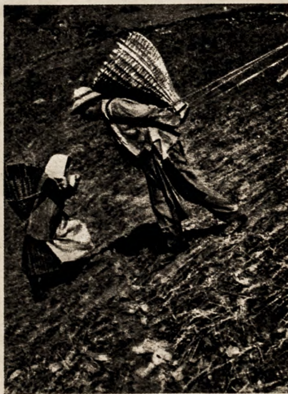
L'aspra fatica dei montanari; attaccate agli estremi di una corda passante per una carrucola posta in alto, due persone provvedono al trasporto del letame o dei prodotti lungo i fianchi di ripidissimo pendio. Quella che scende aiuta l'altra a salire. ( Neg. Moser )
