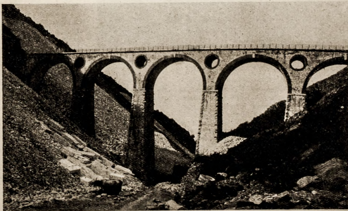
FERROVIA MARMIFERA : VIADOTTO DI VARA
