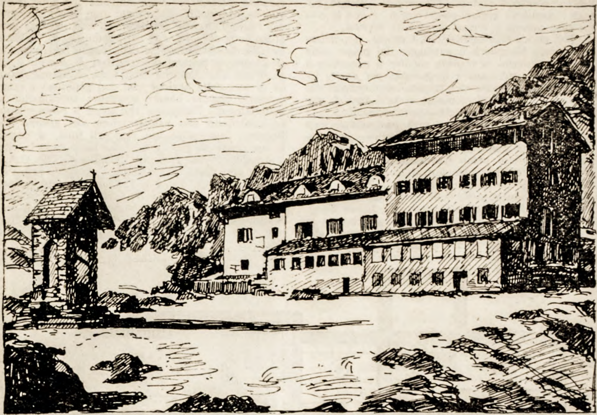
Dopo l'ultimazione dei lavori in corso
