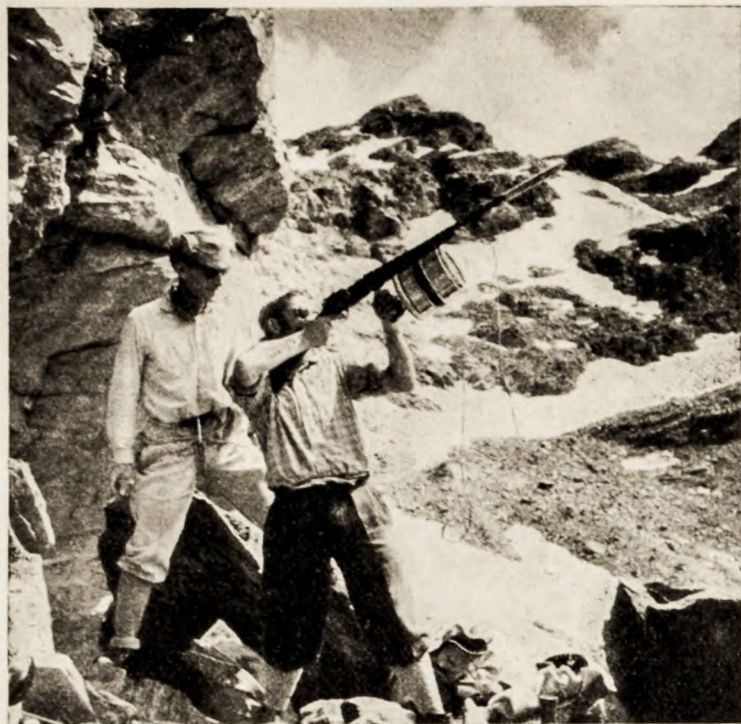
Prova di fucile lanciarazzo con 300 m di cordino (Svizzera).
