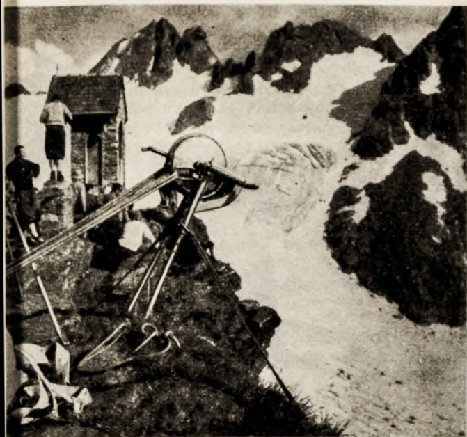
Nuovo tipo di verricello jugoslavo a piatti concentrici oscillanti.
