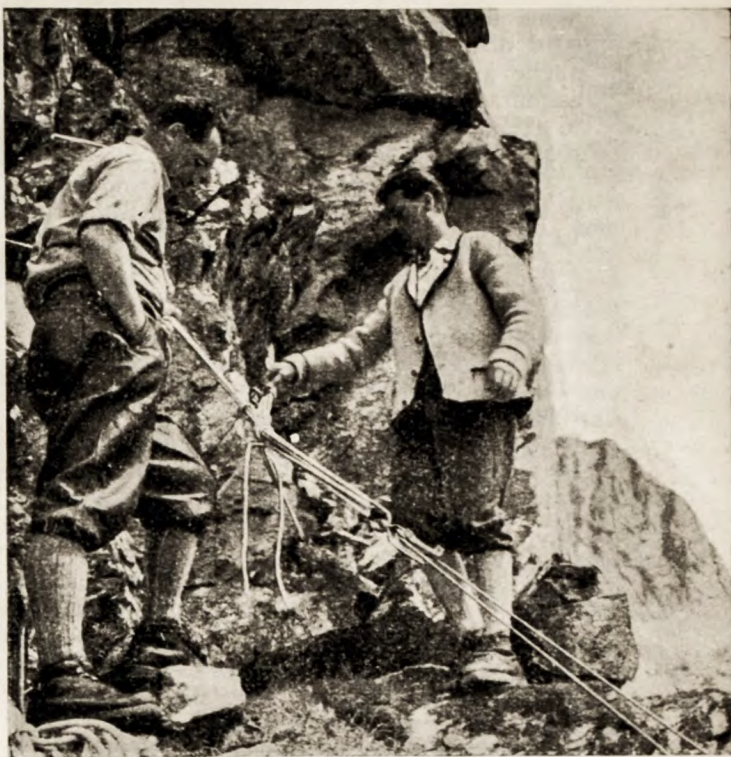
Ancoraggio in alto della teleferica.
