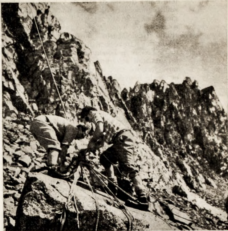
Ancoraggio alla base della teleferica.
