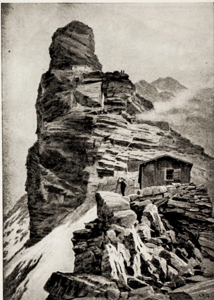
Le due capanne italiane alla Gran Torre. (dis. di Whymper, 1897)
