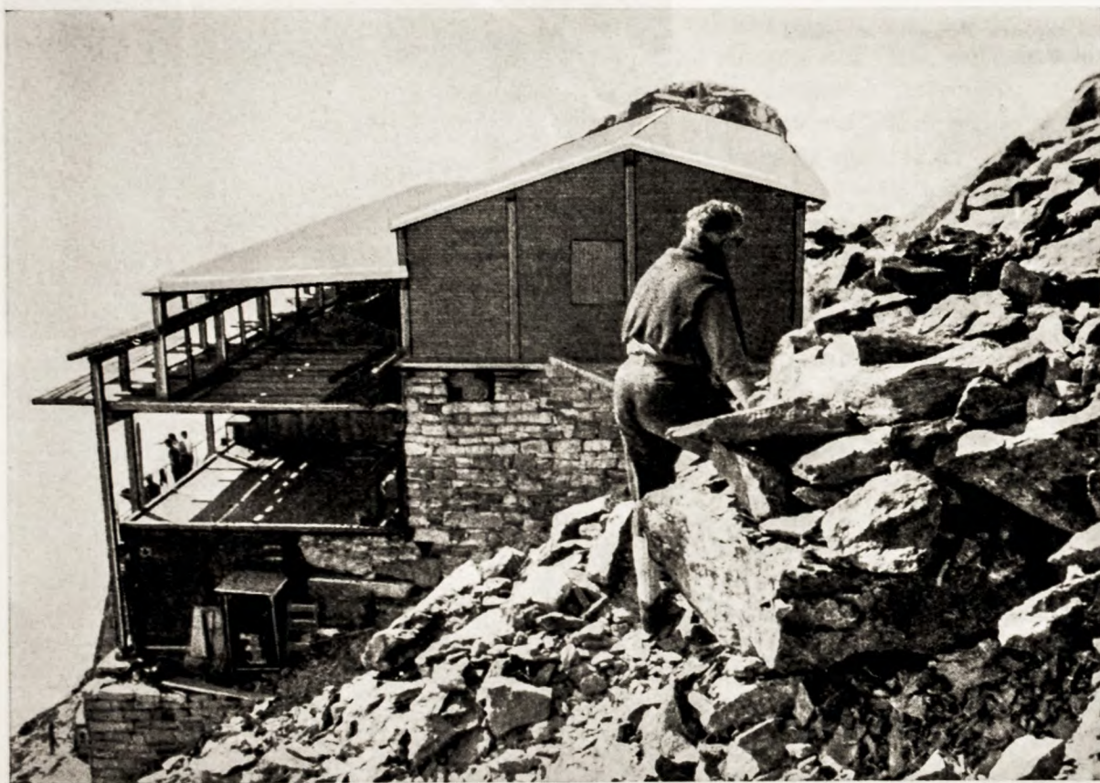
La capanna Gnifetti durante i lavori di ampliamento nel 1967.
