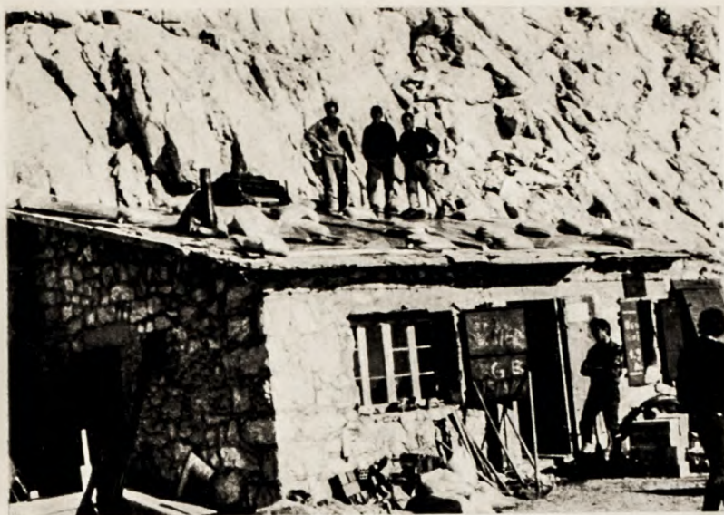
Il rifugio Torrani alla Civetta (3000 m), al termine dei lavori del 1973.
