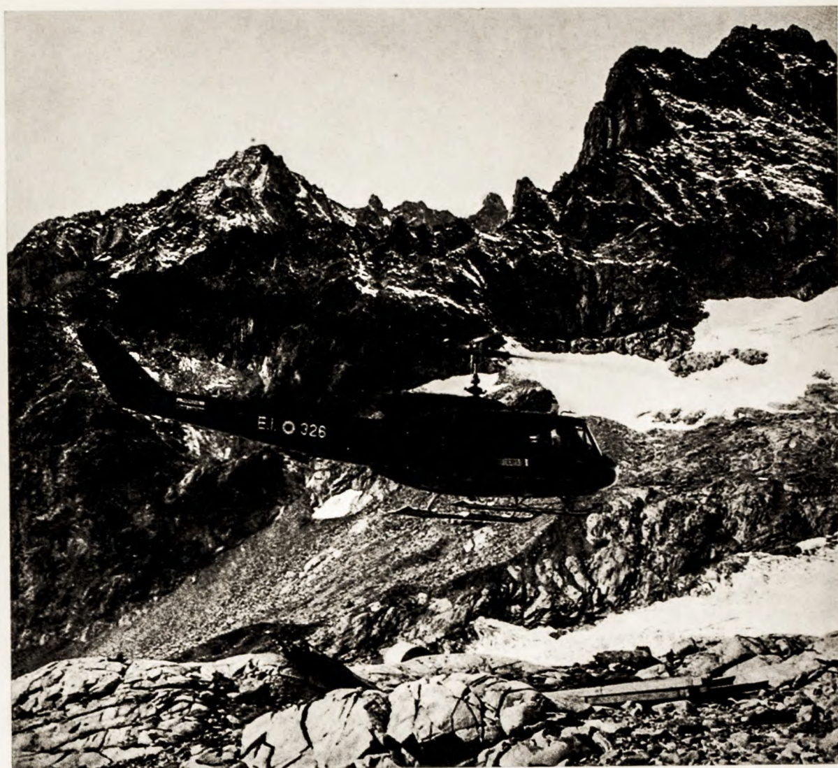
L'elicottero sopra la piazzola di deposito degli elementi del bivacco-fisso.
