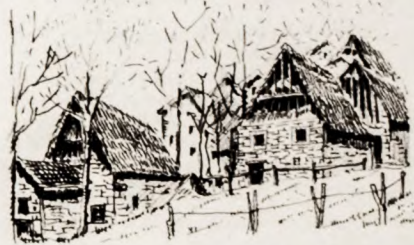
Edifici con il tetto di paglia a Brenzeglio, in Val Dongana (Valle Albano); sono chiamati mason.
