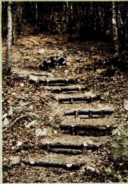
Sistemazione finale con riporto di terriccio e gradinatura lignea del sentiero degradato.
