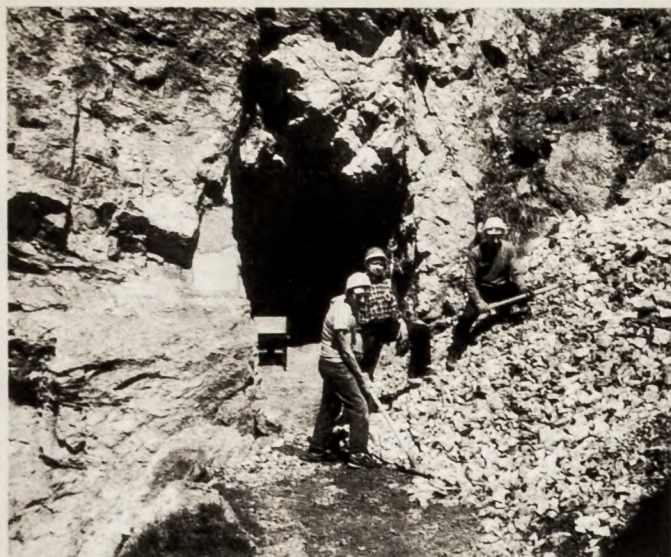
Un momento dei lavori di sgombero effettuati nel 1989.
