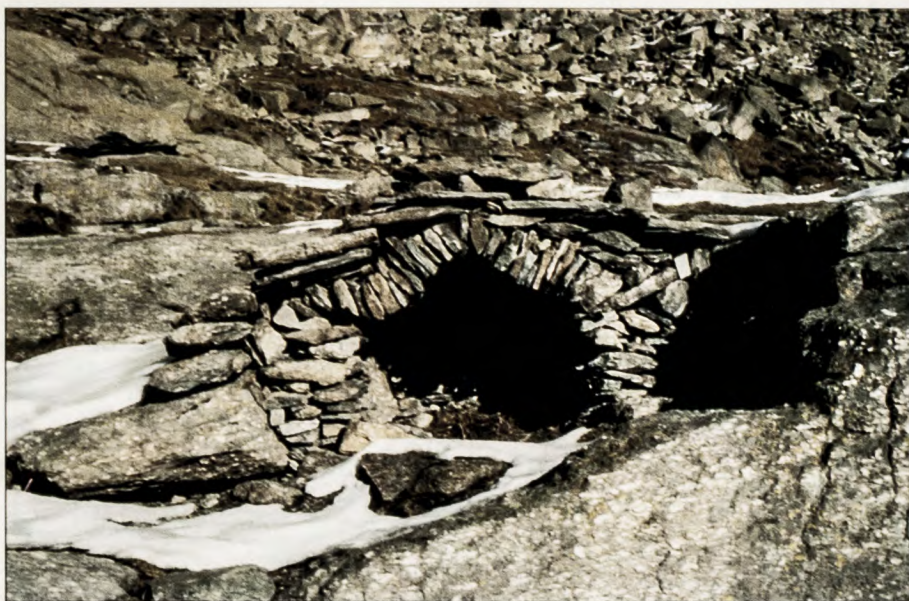
Vallone di Vassola: i ponti ad arco in pietra (f. P.G. Vottero).
