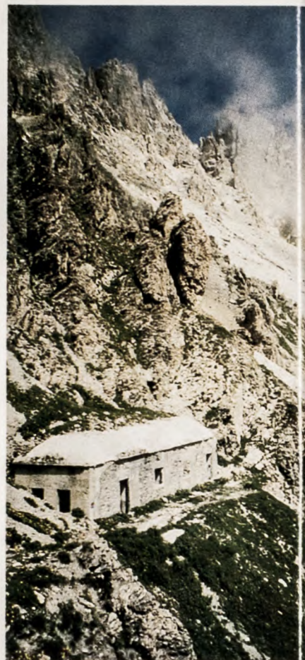
Qui sopra: Ex casermetta nei pressi del Colle Feuillas.
