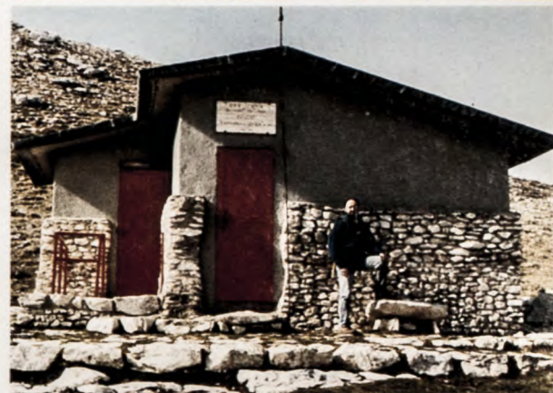
La Capanna di Sevice (m 2119).
