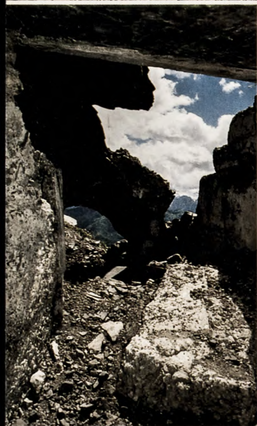
Apertura cementata AR della galleria della mina austriaca.
