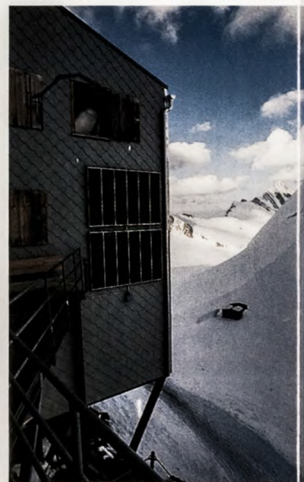
Moduli solari alla Monchslochhütte.
