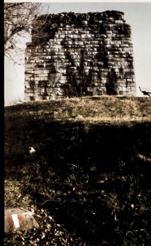
La Torre di Rodero al Colle di San Maffeo. (f. W. Castoldi).
